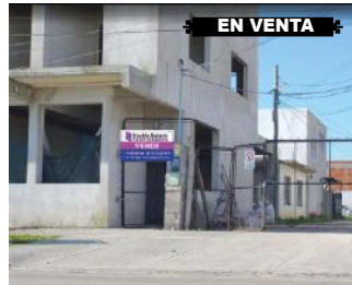
EN VENTA 163 e/ 68 y 69 6800 Guillermo E Hudson. PH. en construcción de dos plantas está en un 40% la planta baja. 3 ambientes. OPORTUNIDAD..... u$s 40.000
