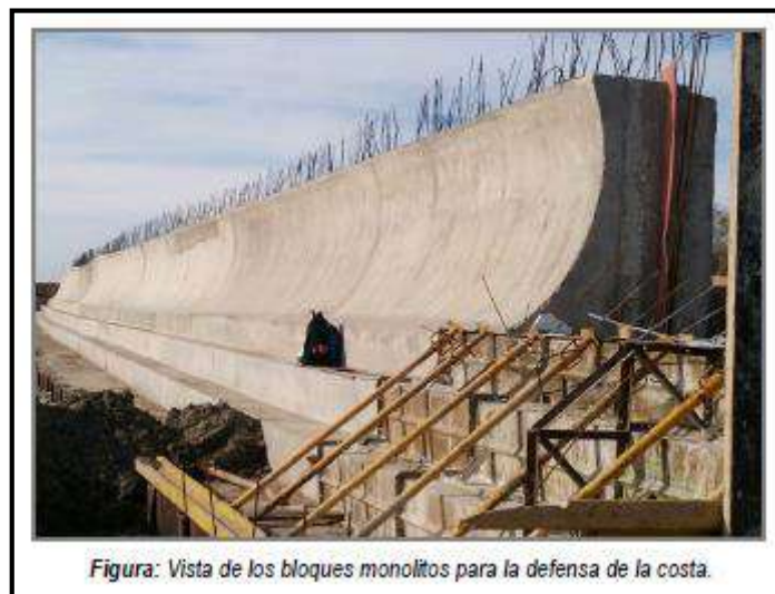
Figura 12: Diseño curvo para la disipación de energía del oleaje.
