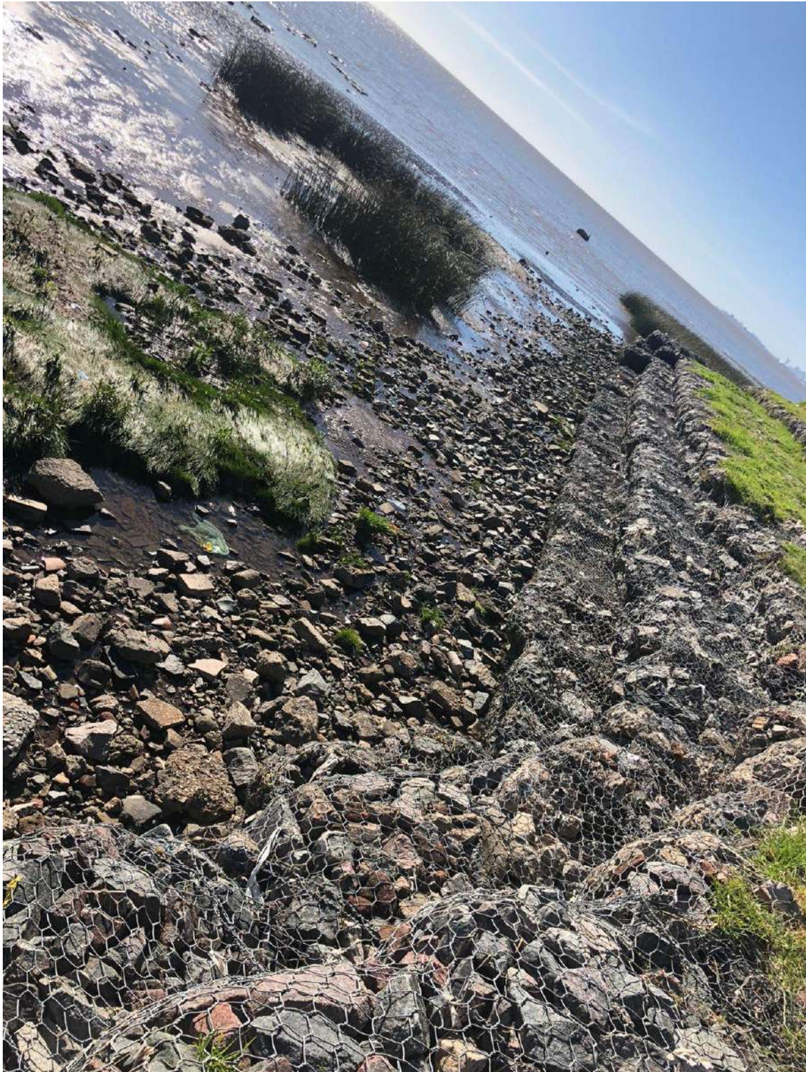
Utilización de gaviones para consolidación de costas
