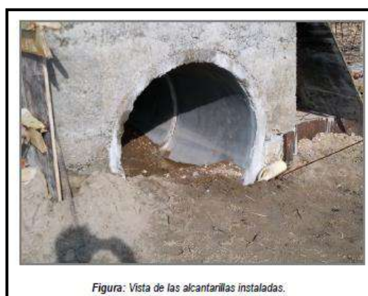
Figura 10: Alcantarilla instalada.
