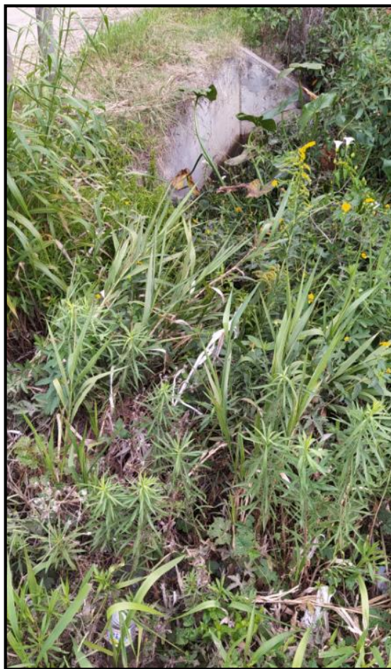
Fotografía 10: Canal Norte Calle 63 – Alcantarilla ingreso predio zona terraplén
