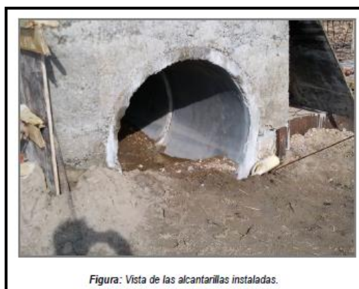
Figura 10: Alcantarilla instalada.
