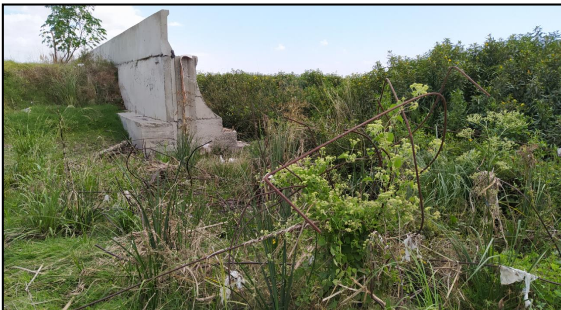
Fotografía 11: Apertura Defensa Terraplén
