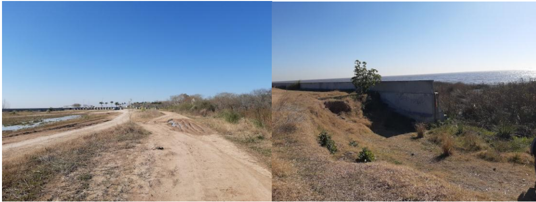
Imagen 4. Situación relevada a campo.
