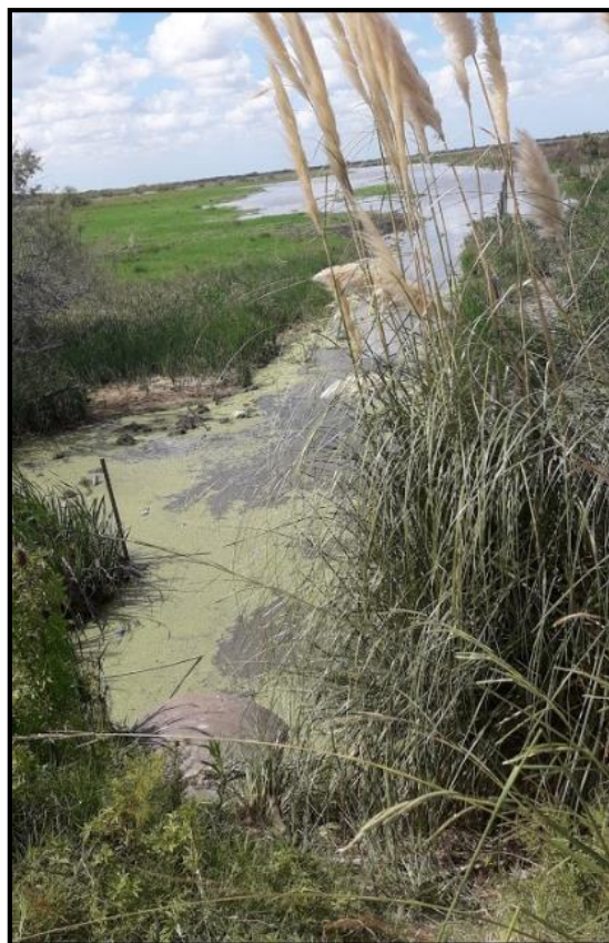
Fotografía 6: Canal Sur Calle 63 – Alcantarilla Cruce Calle 63
