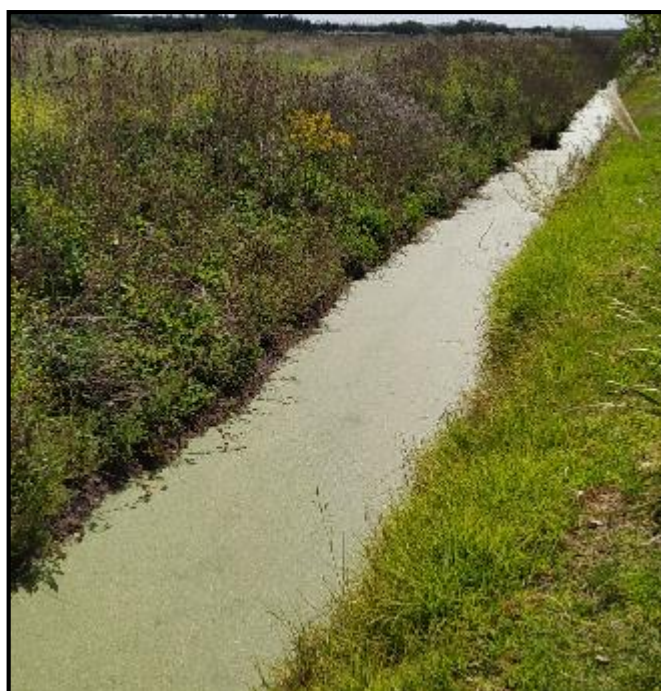
Fotografía 5: Canal Norte Calle 63
