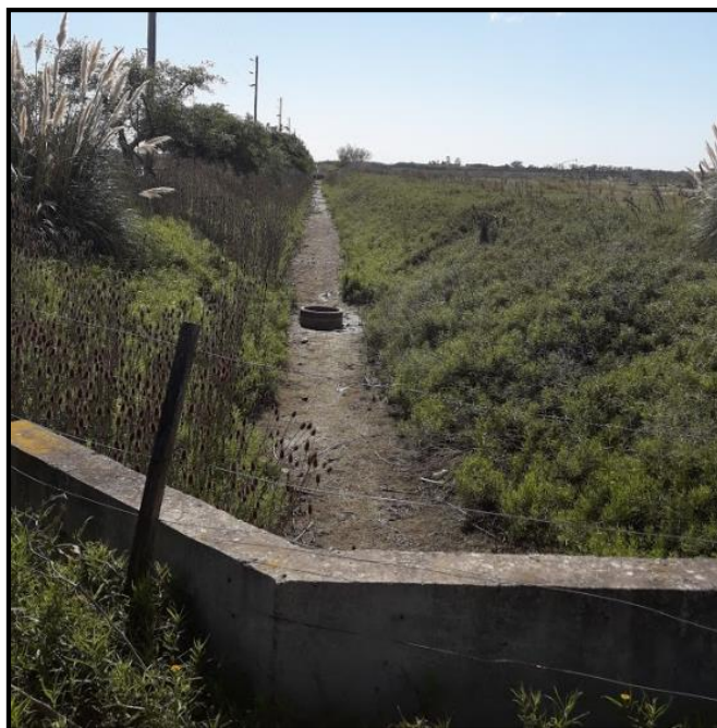
Fotografía 4: Canal Sur Calle 63 – Vista hacia aguas abajo – Alcantarilla Entrada Barrio
