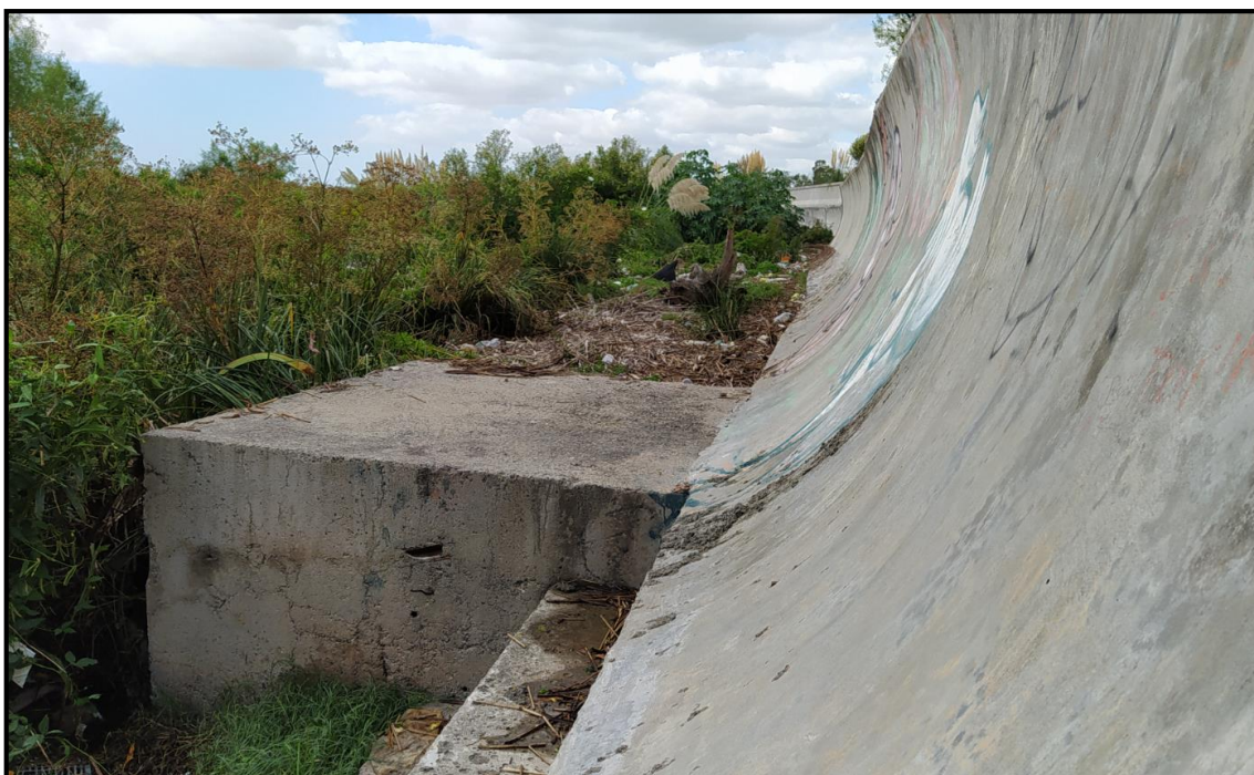
Fotografía 12: Salida Alcantarilla en Defensa
