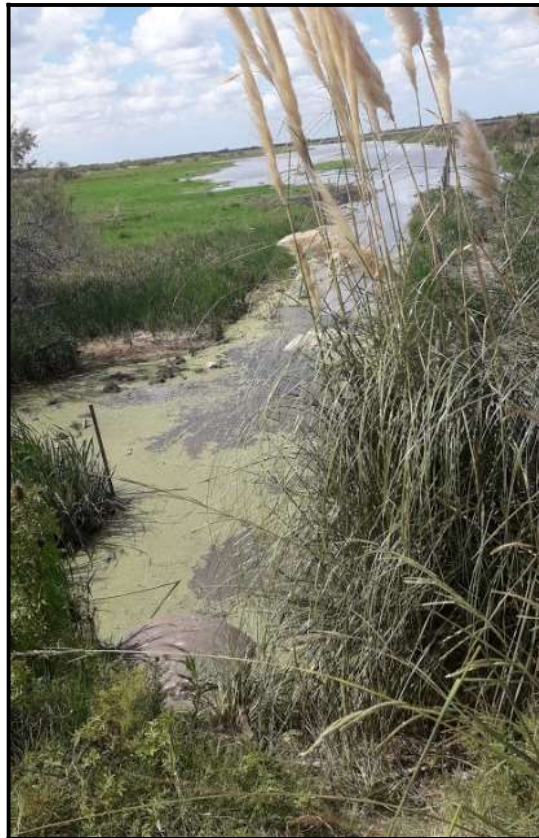
Fotografía 6: Canal Sur Calle 63 – Alcantarilla Cruce Calle 63
