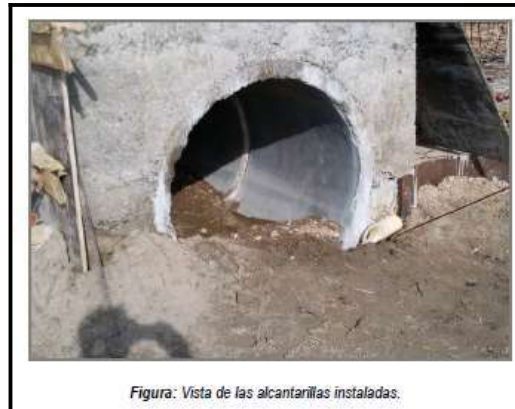
Figura 10: Alcantarilla instalada.
