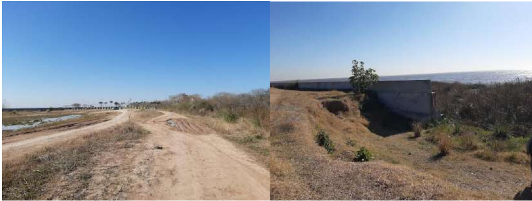
Imagen 4. Situación relevada a campo.
