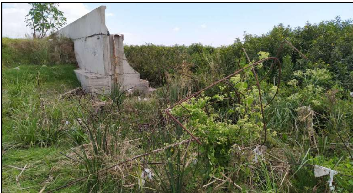
Fotografía 11: Apertura Defensa Terraplén
