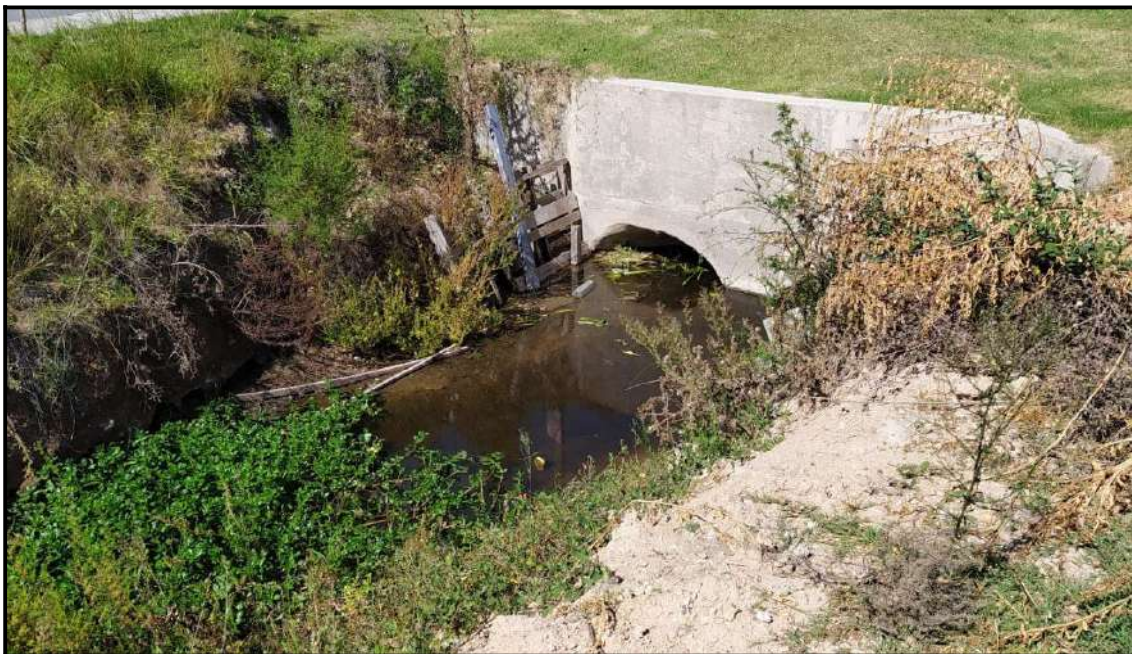
Fotografía 3b: Alcantarilla Entrada Pueblos del Plata – Vista desde aguas abajo
