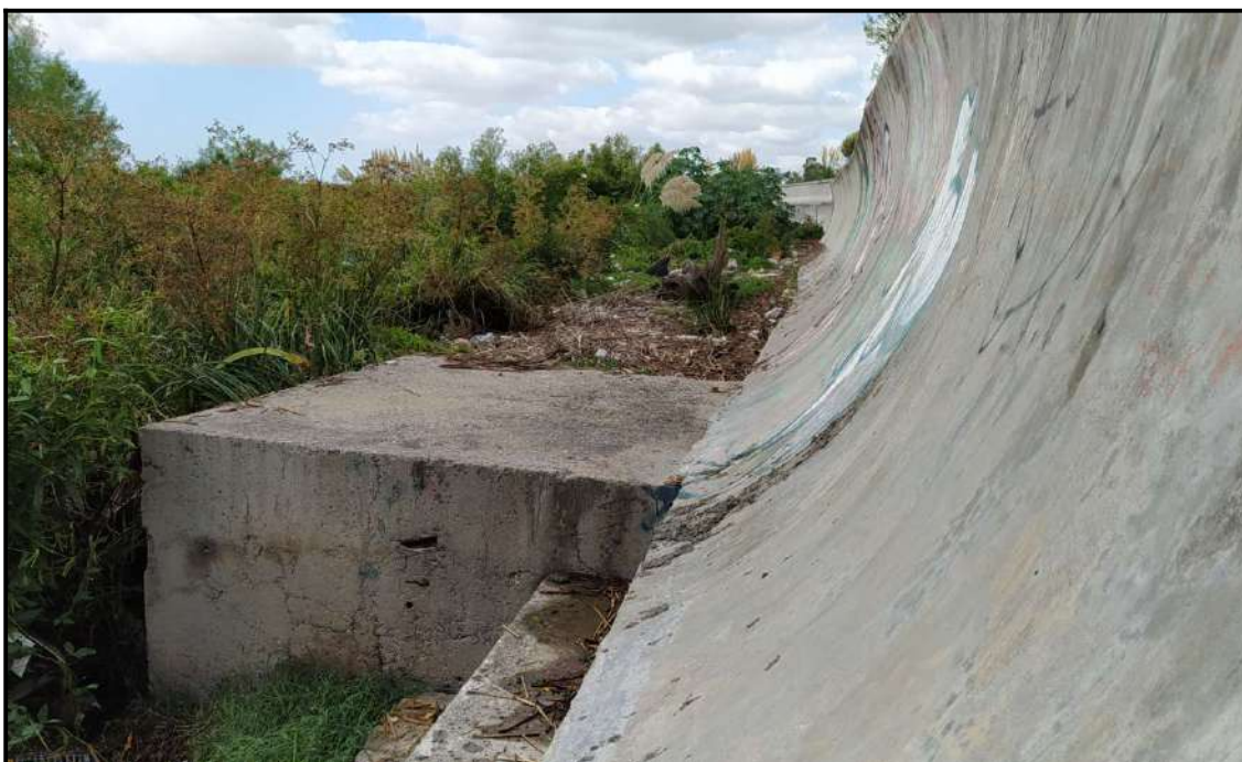
Fotografía 12: Salida Alcantarilla en Defensa
