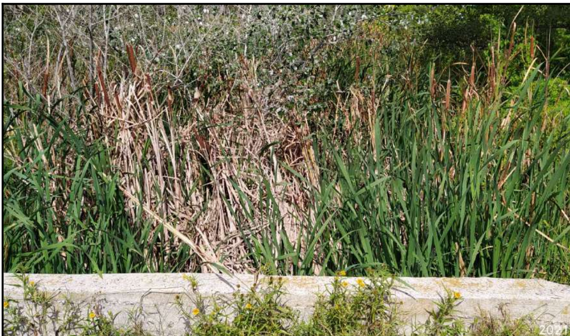
Fotografía 7: Canal Sur Calle 63 – Alcantarilla calle predial
