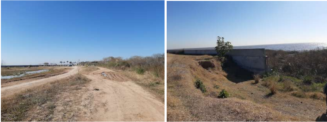
Imagen 4. Situación relevada a campo.
