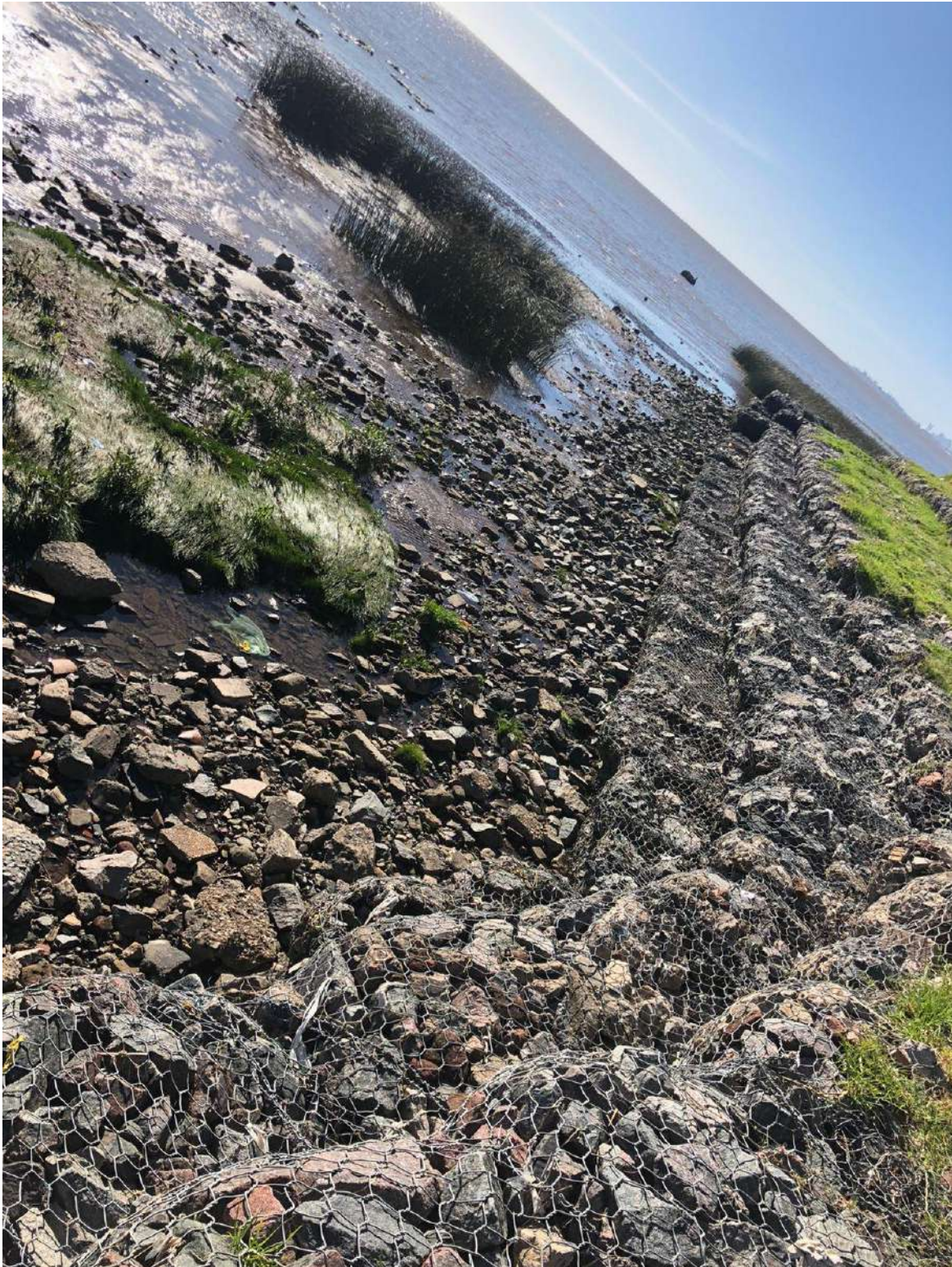
Utilización de gaviones para consolidación de costas
