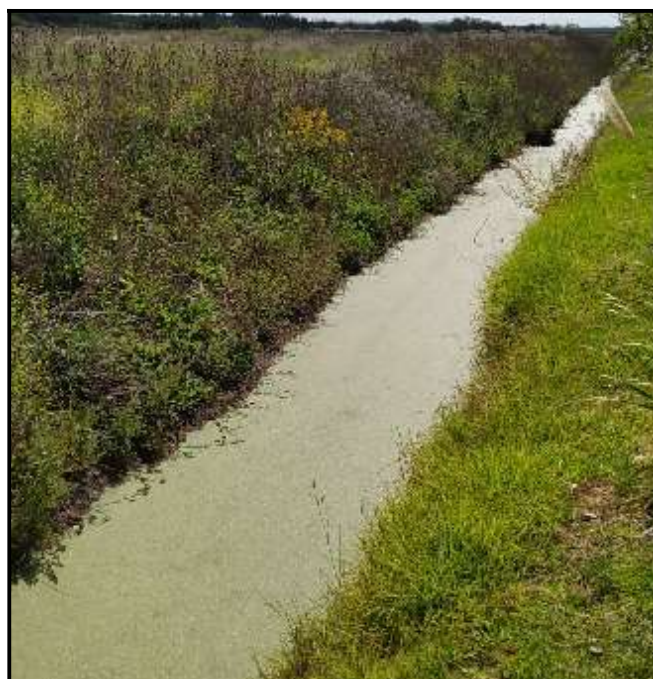
Fotografía 5: Canal Norte Calle 63
