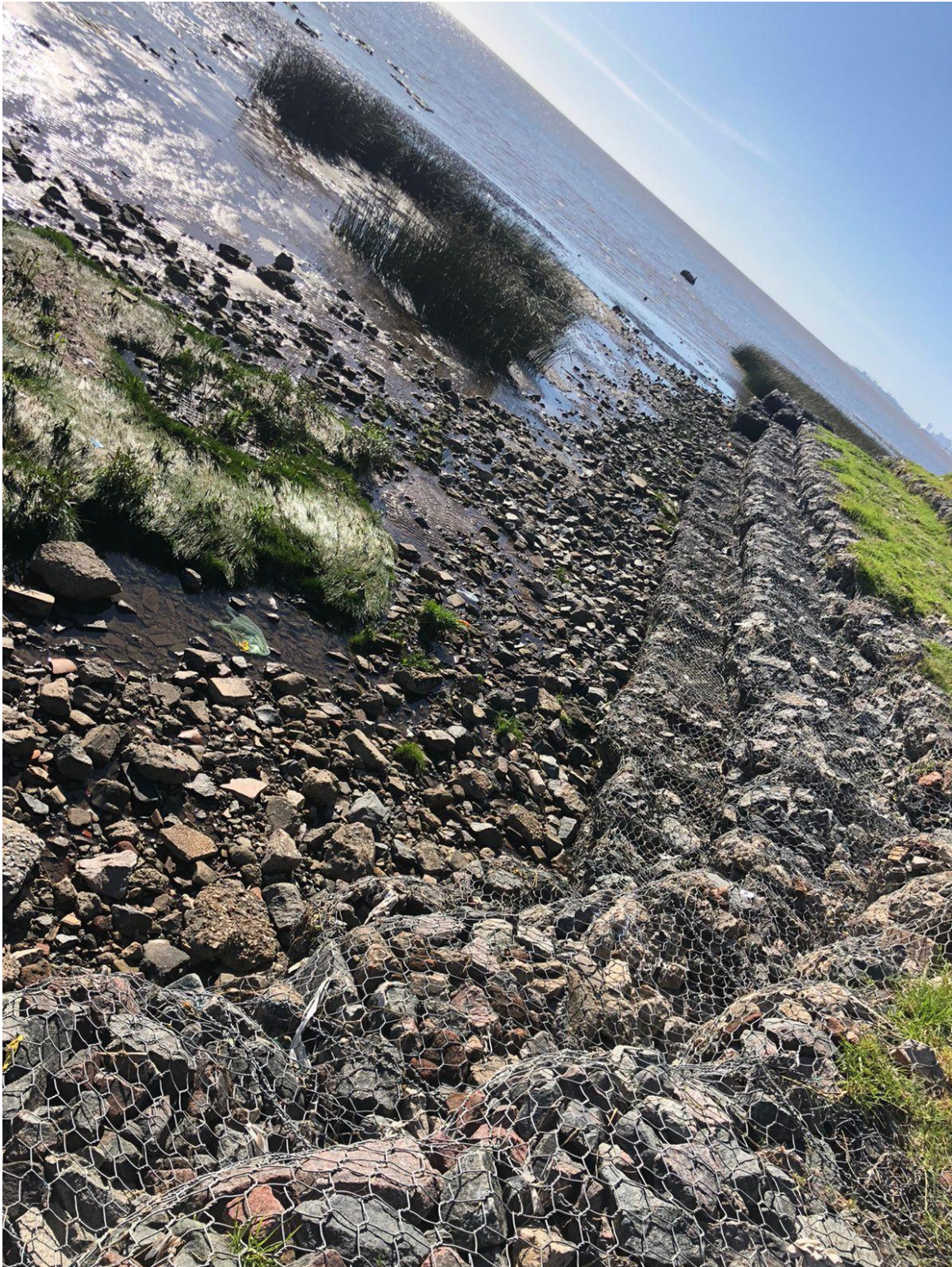
Utilización de gaviones para consolidación de costas
