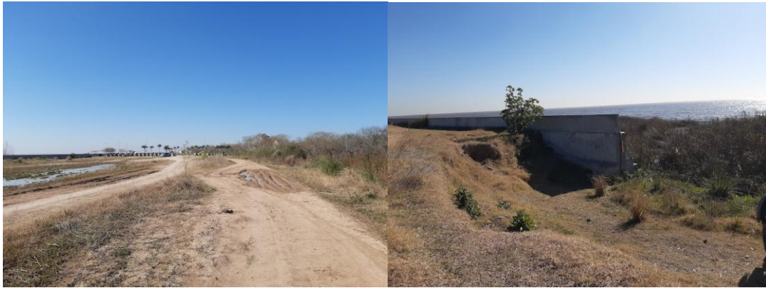
Imagen 4. Situación relevada a campo.
