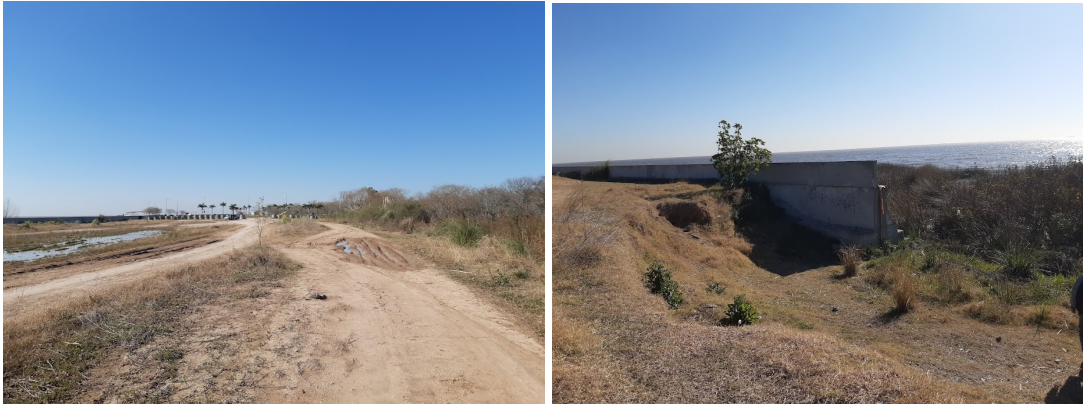
Imagen 4. Situación relevada a campo.
