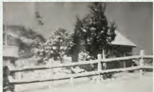
Kalinka, la primer cabaña que construyeron en Llao Llao durante el invierno.
